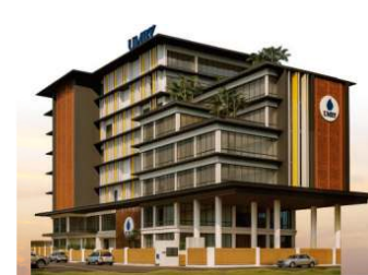
Renovasi Gedung Kampus 2
